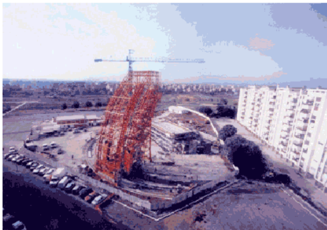
Vista aerea della macchina di montaggio dei conci Top view of the block positioning machine
