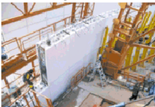
Vista generale dei giunti verticali delle barre e dei tubi d'iniezione General view of the bars and grouting ducts vertical joints
