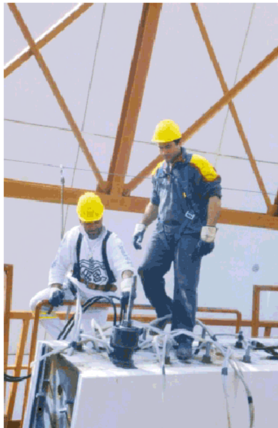
Preparazione del martinetto per il tensionamento dei cavi Setting the pulling jack for cable tensioning
