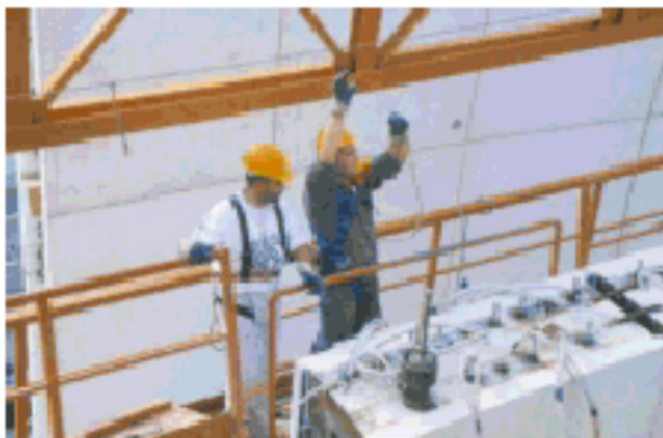
Tensionamento delle barre verticali Vertical bar tensioning
