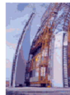
Vista laterale del montaggio delle vele Side view of sail assembling
