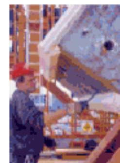
Pulitura dei fori delle guaine Block cleaning
